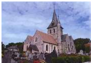
Eglise classée MH
