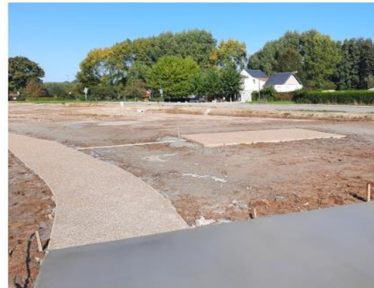
Les surfaces en béton désactivé sont réalisées
