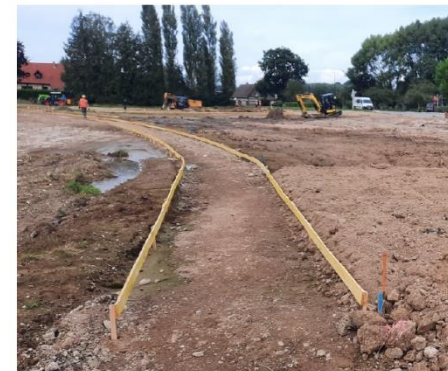
Coffrage et empierrement en cours de la sente
