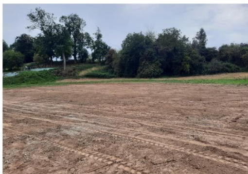
Le nivellement général de la parcelle est bien avancé
