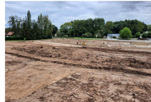
Cheminement en mélange terre / pierre en cours
