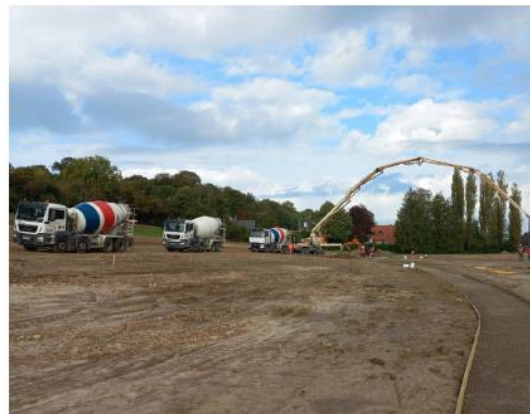
Le coulage du béton le lundi 10 octobre 2022
