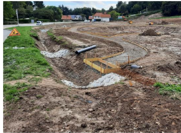
Les redans sont réalisés
