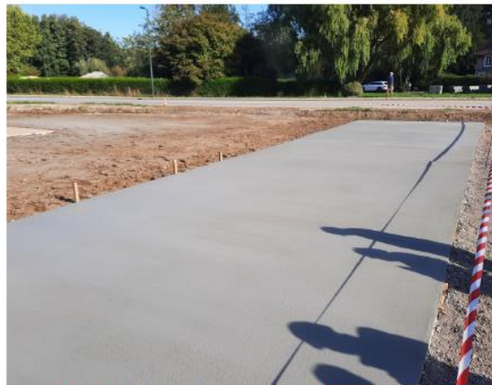
L'aire de stationnement en béton est coulée
