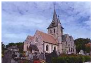
Eglise classée MH
