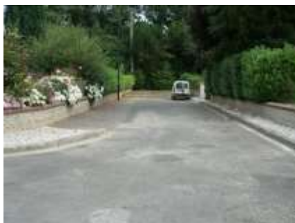
Voirie tertiaire : cavées, voies communales étroites
