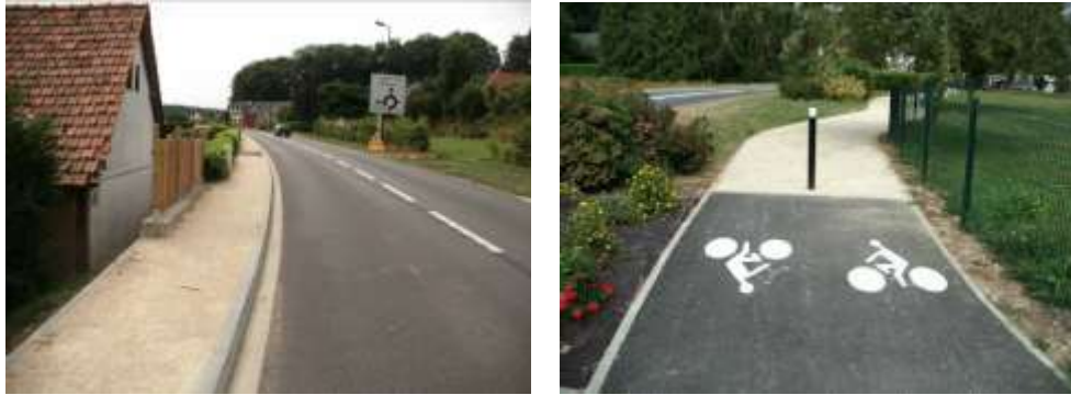
Aménagements permettant des circulations piétonnes et cyclistes sécurisées en bordure des voiries principales
